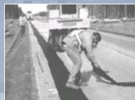
Aszfalt burkolatú út készítése
